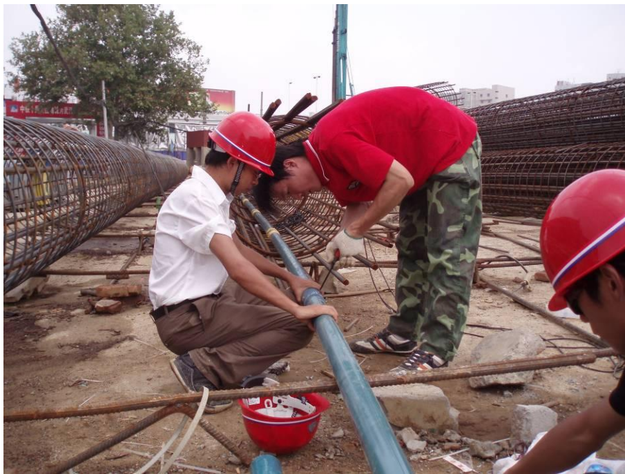
钻孔灌注桩测斜管安装
